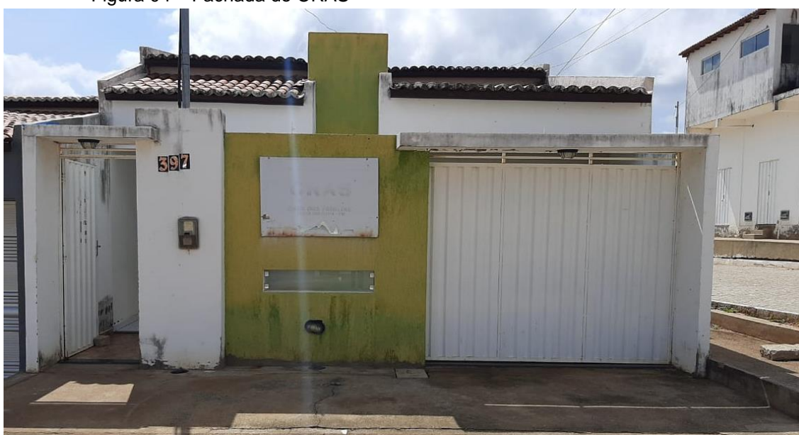
Figura 04 – Fachada do CRAS
